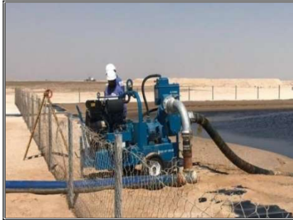
De-watering (water pit)
